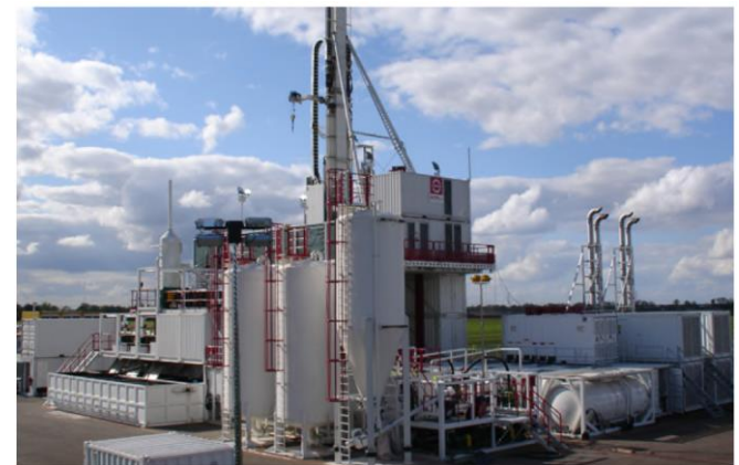
Figuur 3.3: Boorinstallatie DrillTec VDD 370 (bron http://www.drilltec.de/en/drilling-rigs/vdd-rigs.html )
